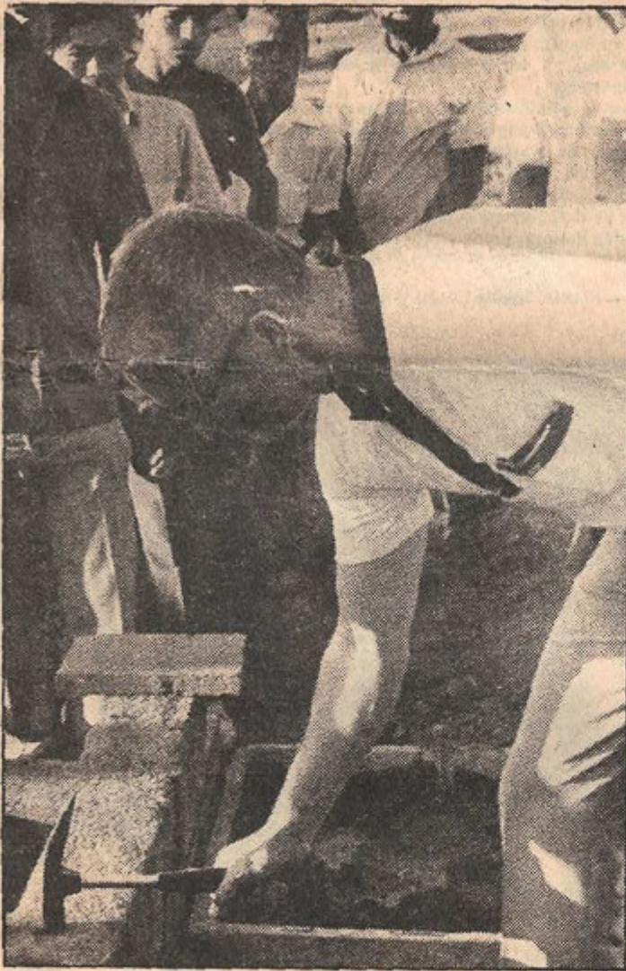
El Embajador de la RDA en Nicaragua, Henry März, coloca la primera piedra de la segunda etapa del hospital Carlos Marx.
