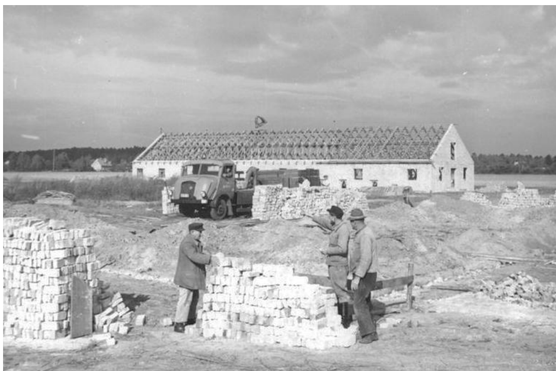
Imagem 11. A brigada de construção da LPG constrói um depósito de ração em 19 de outubro de 1955. Entre abril e outubro daquele ano, a brigada de construção completou três novos estábulos. Até 1960, a brigada havia construído baias de parição e espaços para suínos, gado e aves. Todos esses grandes projetos de construção foram concluídos com a ajuda de trabalhadores voluntários da construção civil.
