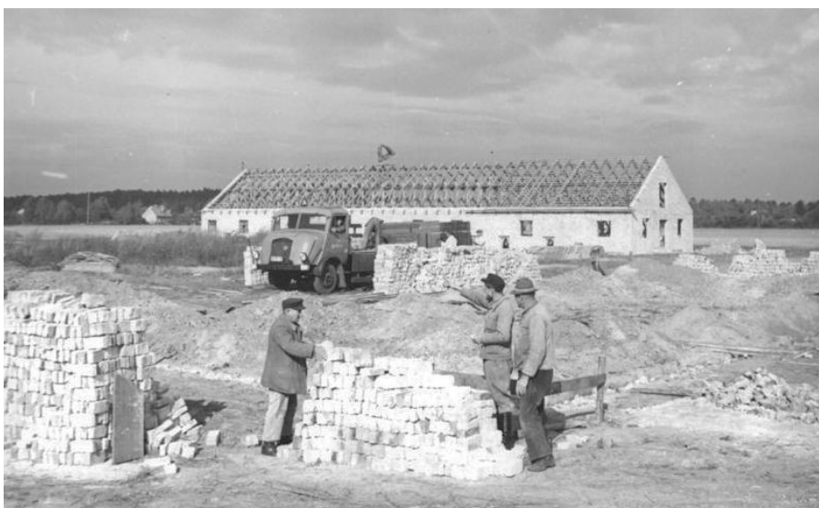
Fotografía 11. La brigada de construcción de la LPG construye una nave de forraje el 19 de octubre de 1955. Entre abril y octubre de ese año, la brigada de construcción terminó tres nuevos establos. Hacia 1960, la brigada había construido parideras e instalaciones combinadas para cerdos, ganado vacuno y aves de corral. Todos estos grandes proyectos de construcción se completaron con la ayuda de trabajadores voluntarios de la construcción.
