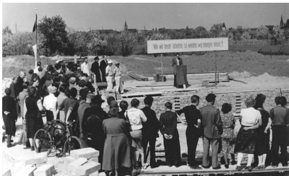
Fotografía 10. El 19 de mayo de 1954, la LPG Freie Erde [Tierra Libre] de Magdeburg-Salbke construye un gran patio agrícola. Las campesinas y campesinos de la cooperativa colocaron la piedra fundamental junto con trabajadores de empresas industriales vecinas. El cartel dice: "¡Como trabajamos hoy es como viviremos mañana!".
