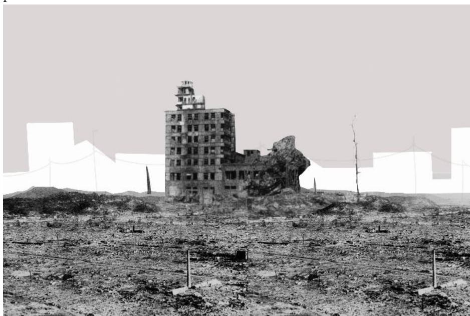
Satsuo Nakata, bâtiment Chugoku Shimbun, 10 août 1945.
